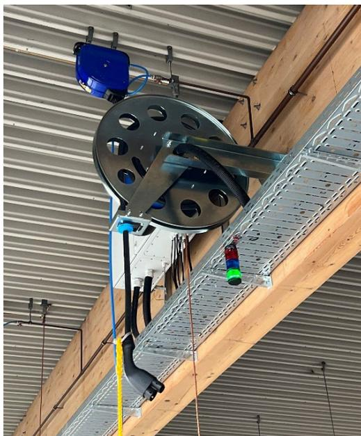
a) Kabeltrommel mit Rückspulfunktion;
