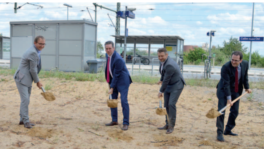
An der Bahnstation Calbe (Saale) Ost wird mit dem Bau einer neuen Verkehrsschnittstelle begonnen.
